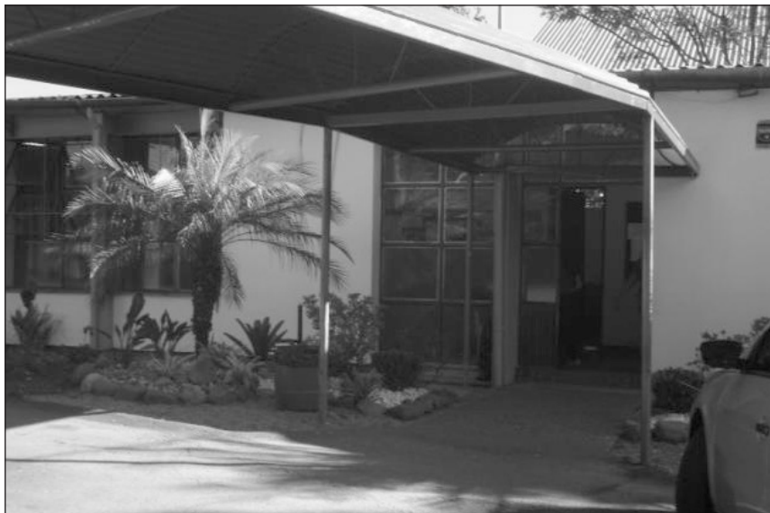
Vista externa do Administrativo.
