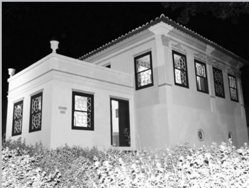
Casarão dos Fonseca restaurado – sede da Casa dos Açores do Estado do Rio Grande do Sul.
