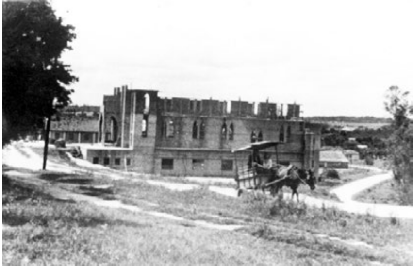
Aspecto da construção da Igreja Matriz São Francisco de Paula. Cachoeirinha. s/d.
