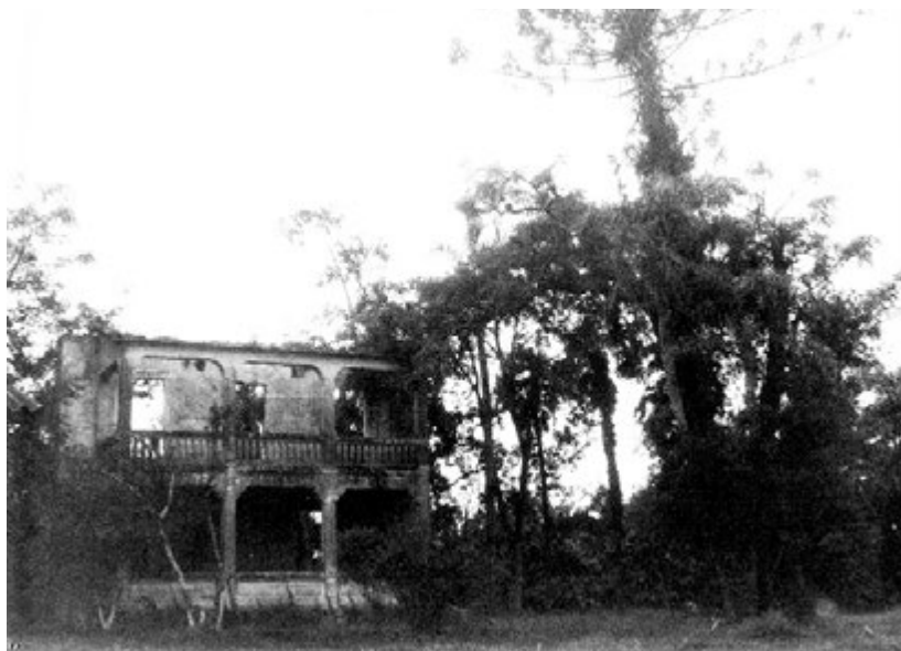
Ruínas da sede da propriedade de Alberto Bins, em Cachoeirinha.
