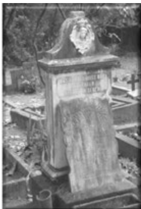
Túmulo construído em técnica "fachwerk" (enxaimel).
